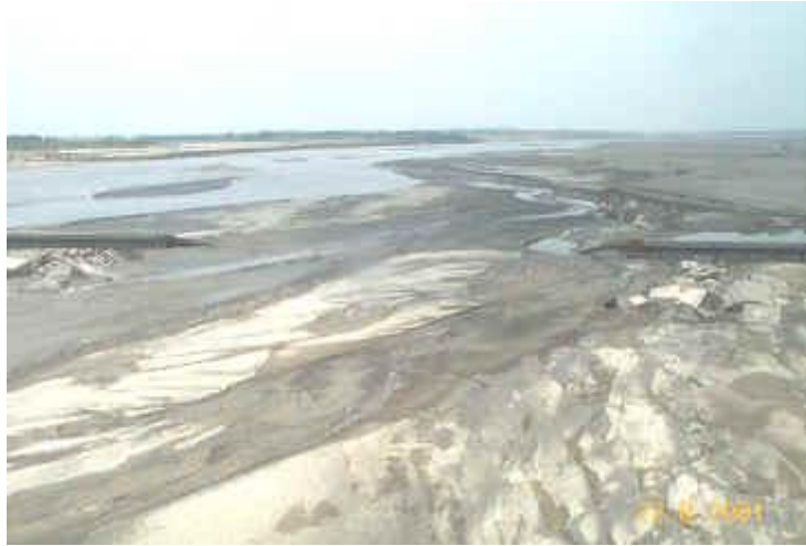
圖 7 洪流後西螺大橋下游側混凝土方塊固床工流失情形
