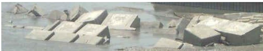
圖 9 洪流造成混凝土方塊固床工散亂之情形
