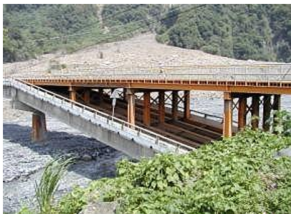
圖 4 十八重溪橋 A2 端陷落架設鋼便橋
