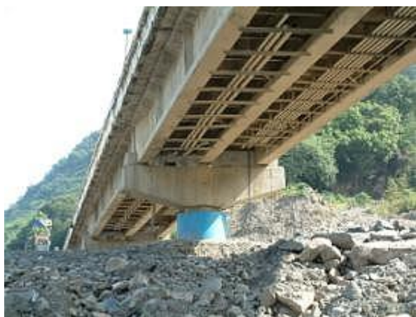
圖 11 帽梁植筋加設垂直及水平方向止震塊
