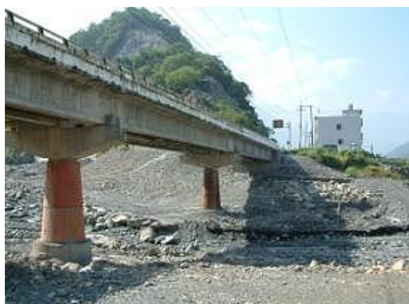
圖 12 A2 橋台及橋面版修復完成
