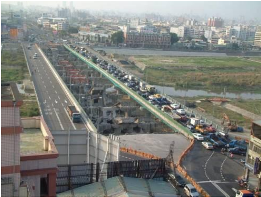
相片四：大里橋改建上游側橋完成後車輛改道情形
