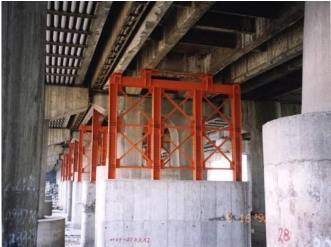
相片二：大里橋桃芝颱風後橋墩緊急加固
