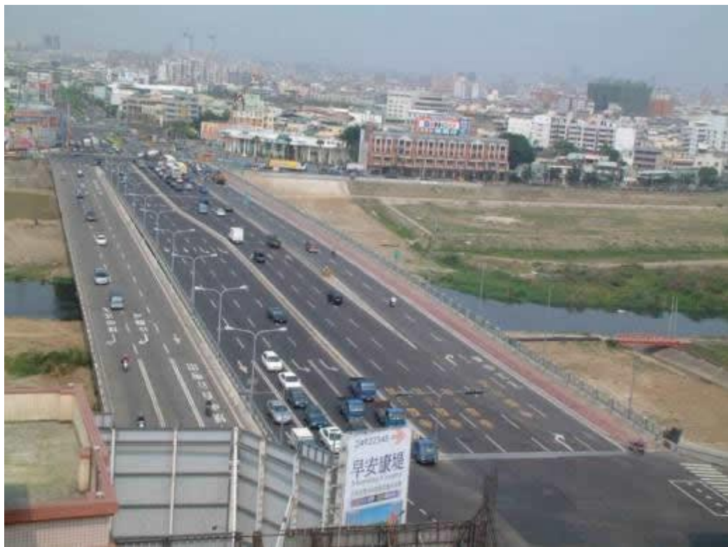
相片五：大里橋改建完成後橋面寬敞
