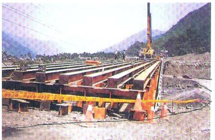
圖八 第二階段便道通車（第三階段鋼便橋施工中）
