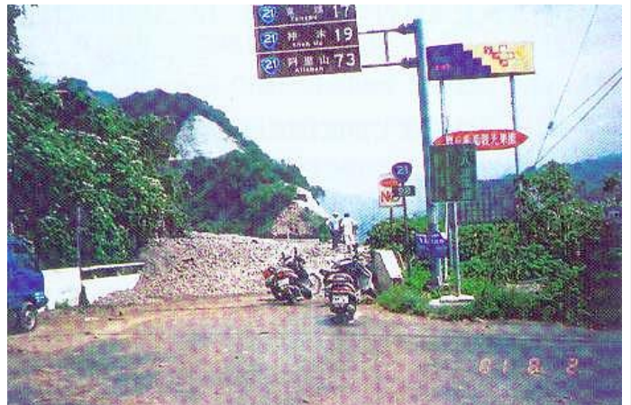
圖二 土石流覆蓋十八重溪橋情形
