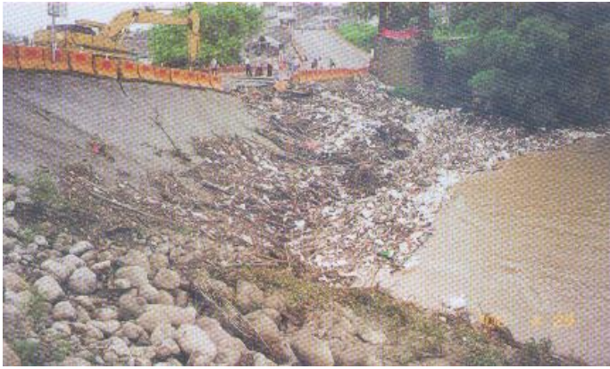
照片 9 第一次潰堤便道上游側涵管堵塞情形
