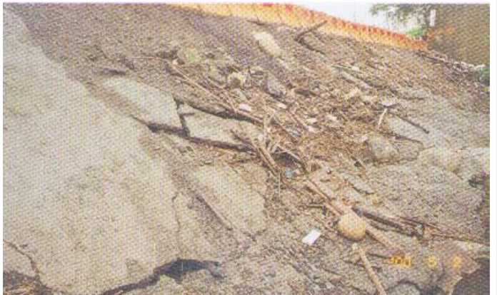
照片 10 第一次潰堤便道上游側 PC 護坡遭流木撞擊產生裂縫
