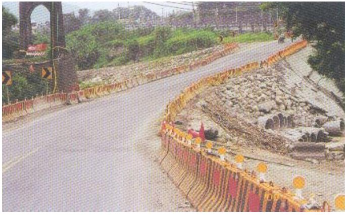
照片 15 第二次潰堤便道修護後情形
