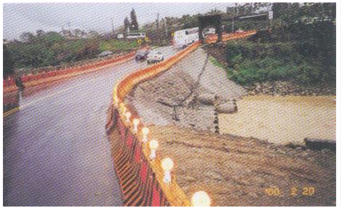
照片 6 石圍橋下游處護岸亦遭震毀傾倒
