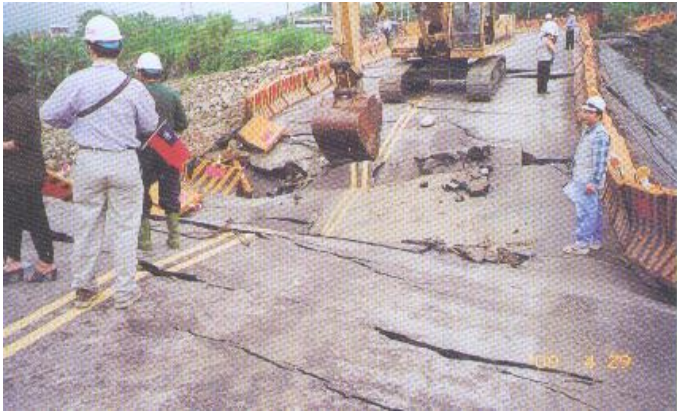
照片 11 第一次潰堤便道路面下陷情形
