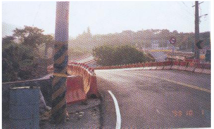
照片 4 臨時便道竣工後通車情形（卓蘭端）
