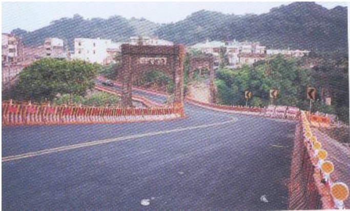
照片 3 臨時便道竣工後通車情形（東勢端）
