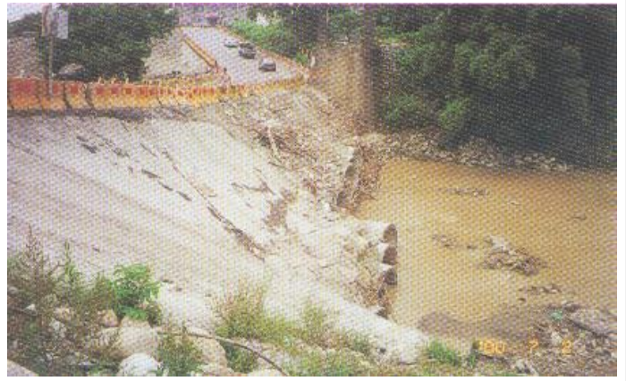
照片 16 第二次潰堤便道修護後情形
